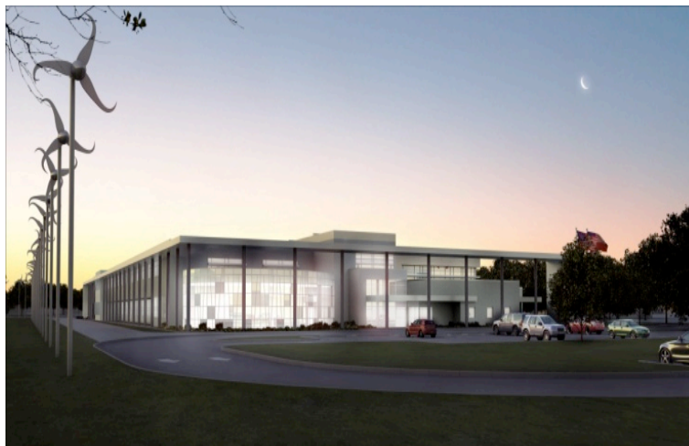
Εικόνα 1: Το ZEB σχολείο Lady Bird Johnson Middle School, Irving, Texas
